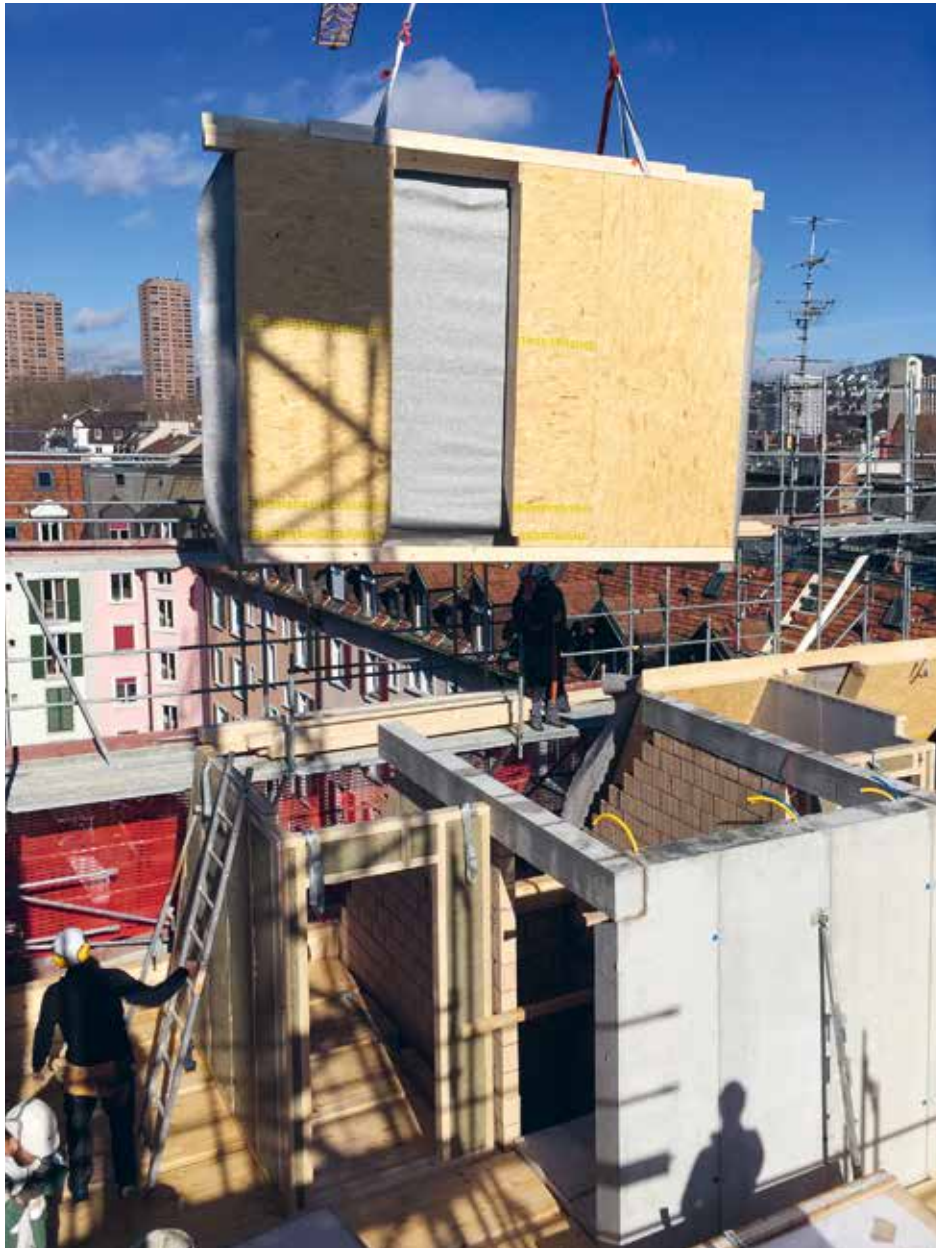
Aufgrund des geringen Gewichts kam für die Aufstockung nur Holz infrage. (Bild: Mirjam Lerch)
