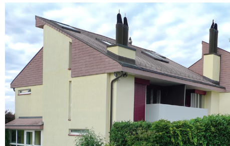
MuKEn sind noch lange kein Verbot von Ölheizungen
