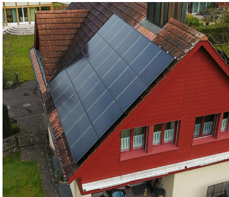
Ein EFH kombiniert Ölheizung mit Photovoltaik
