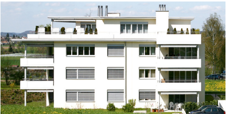
Gebäude 1990 und jünger
